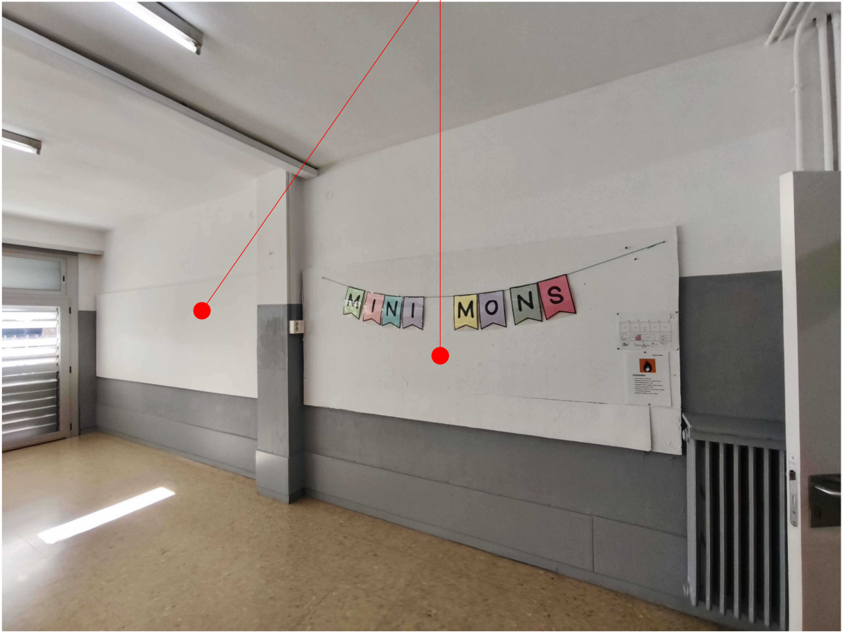
RETIRADA DE TOT EL SURO ADHERIT A LES PARETS DE LES AULES
